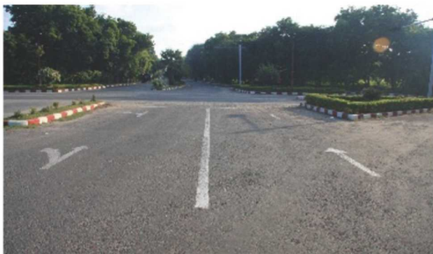
バガン市内交差点路面標示 (写真 5)
