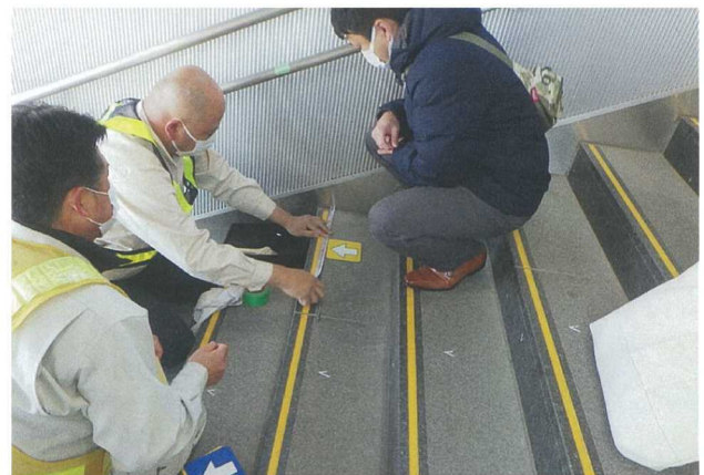
津田山駅自由通路における施工
