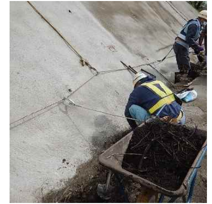
作業時なるべく離隔を確保
