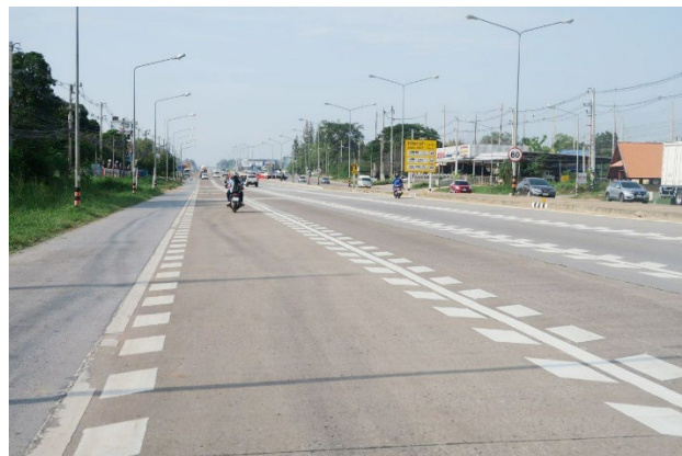
写真—2 減速マーク（オプティカルスピードバー）の設置
