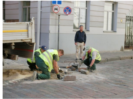
石畳の補修作業（リトアニア）
