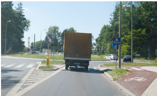
自転車道が別になったラウンドアバウト
