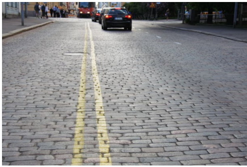
追越しのための右側部分はみ出し通行禁止線
